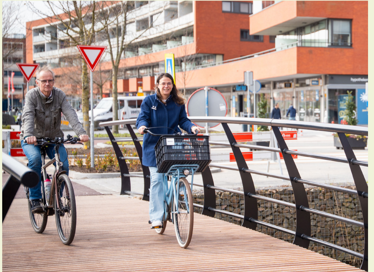
■ Wethouder Jauharina Oelfke-ten Seldam (Verkeer) en William Nederpelt (Fietsersbond Drechtsteden) namen de fietsbrug van de Laan van Welhorst naar Zalm officieel in gebruik door samen als eerste over de brug fietsen. Fotografie: vanderwalbeeld.nl.
