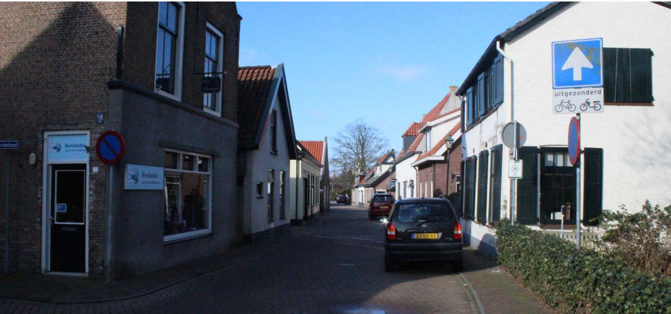
Karakteristieke kleinschalige bebouwing langs de Dorpsstraat, in de oude dorpskern
