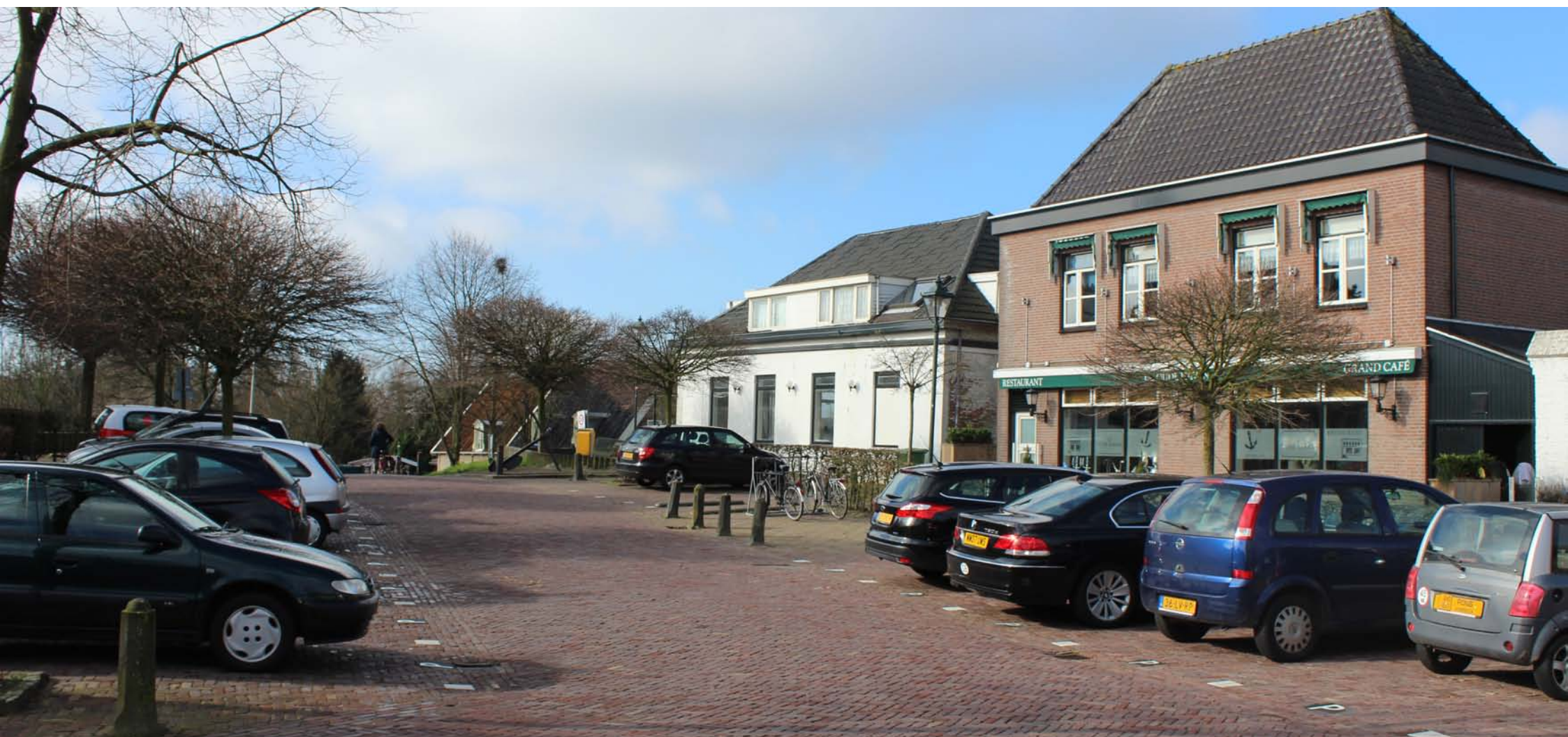
Horecavoorzieningen aan het Havenhoofd
